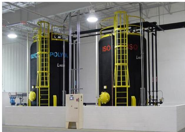
Figura1. Control de nivel de compuestos químicos al interior de contenedores para la confección de espuma de colchones.
